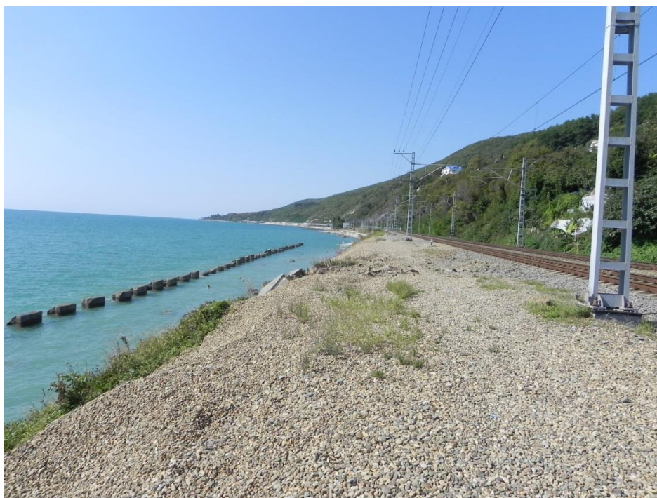
Рис. 3. Прерывистый волнолом на 1911-м км СКЖД (2018 г.)
