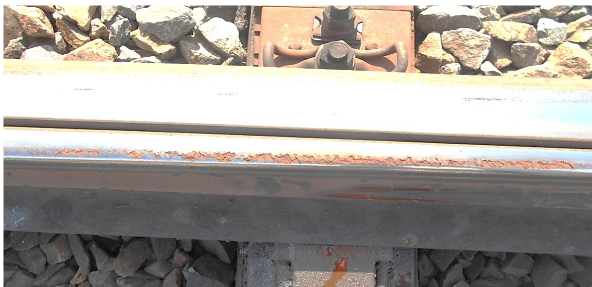
Рис. 3. Пример выкрашивания остряка по коду дефекта ДО.11.2 на опытном участке дороги
