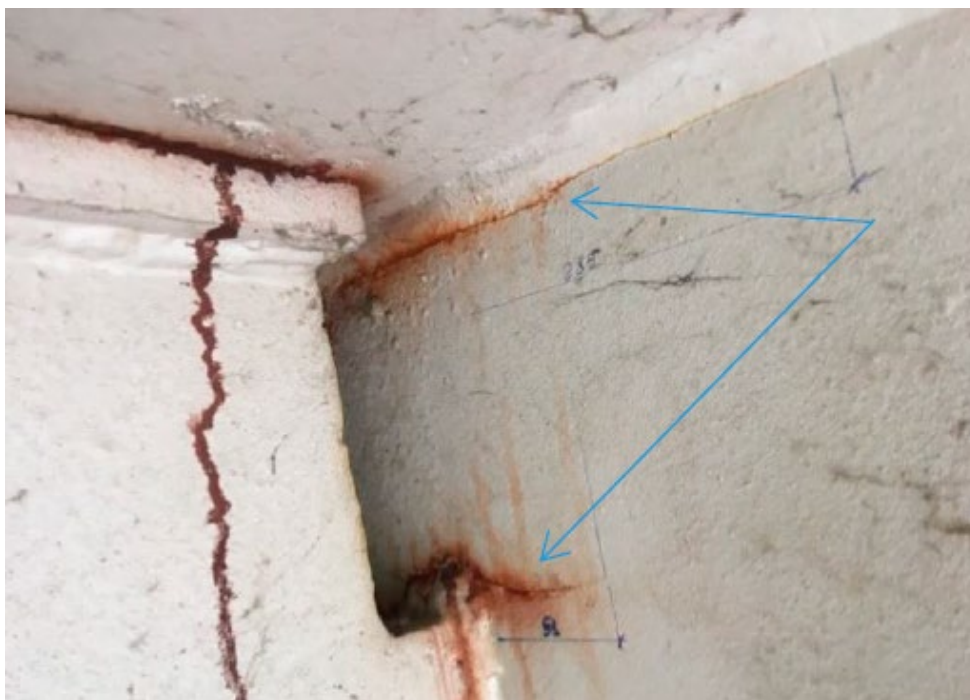
Рис. 1. Усталостная трещина в стенке балки в узле прикрепления ребра жесткости (мост через р. Протоку на 62 + 590 км автодороги А-289)
