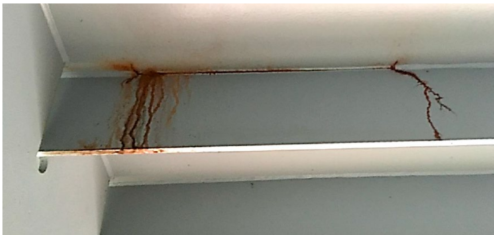
Рис. 2. Усталостная трещина по сварному шву прикрепления продольного листа к листу настила и в продольном ребре (мост через р. Иртыш (левый) на 813 + 748 км автодороги Р-254)
