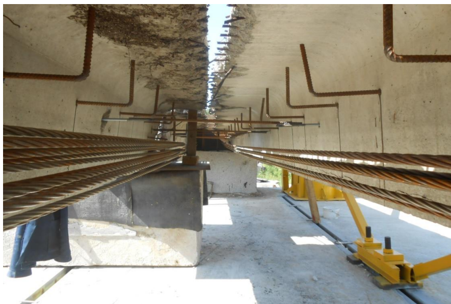
Рис. 5. Пучки канатов К-7 при монтаже фрагмента пролетного строения
