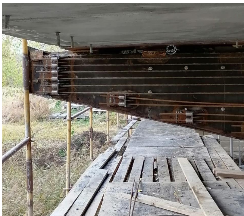
Рис. 11. Установка и натяжение арматурных канатов на ригелях. Работа с подвесных подмостей
