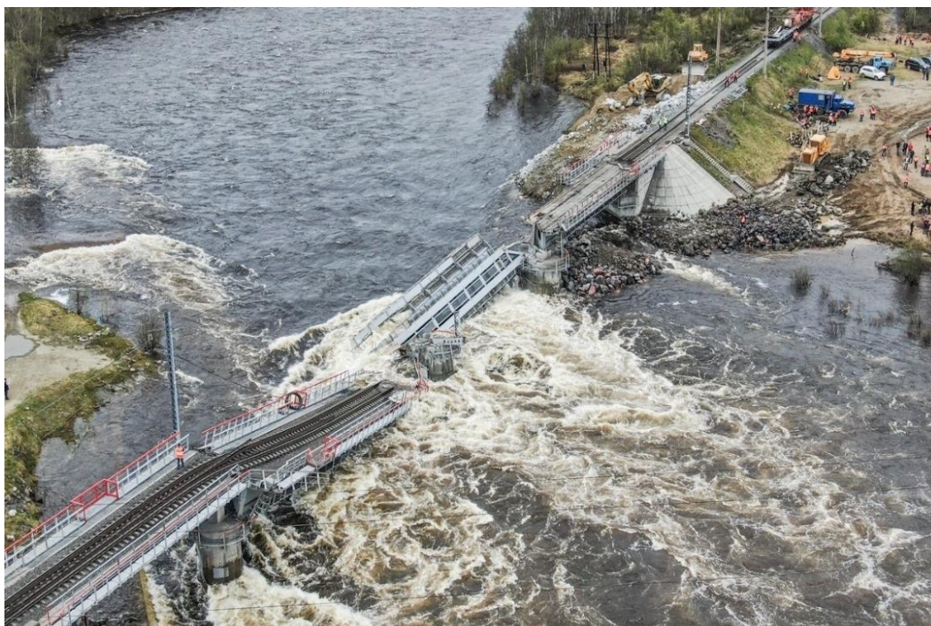
Рис. 1. Последствия аварии на железнодорожном мосту через р. Северная Кола вследствие размыва грунта у русловой опоры
