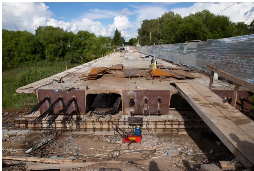
Рис. 10. Преднапряжение пучков в коробке
