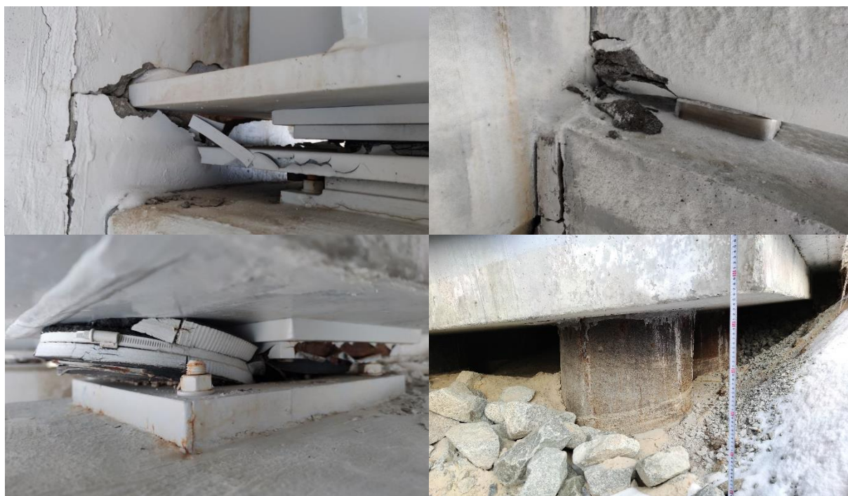
Рис. 1. Примеры повреждений конструктивных элементов автодорожных мостов, устои которых были смещены из-за деформаций грунтов
