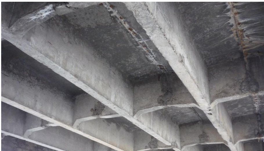
Рис. 1. Железобетонное пролетное строение с поперечными диафрагмами из балок L = 14,06 м, выполненное по типовому проекту СДП, вып. 56. Вид снизу
