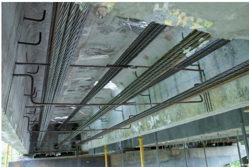
Рис. 9. Преднапряжение шести канатов из 12 прядей диаметром 15,7 мм
