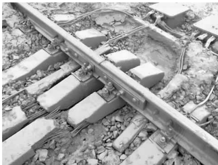
Рис. 2. Разрушение железобетонных шпал, вызванное локальным выплеском пути
