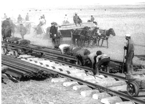
Рис. 1. Укладка железнодорожного пути вручную в послевоенные годы
