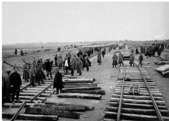
Рис. 1. Укладка железнодорожного пути вручную в послевоенные годы
