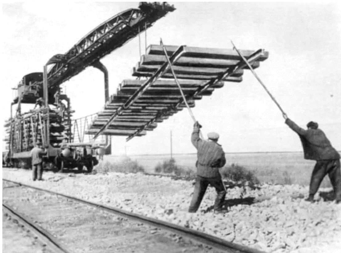
Рис. 2. Укладка железнодорожного пути вручную с использованием путеукладчика Платова
