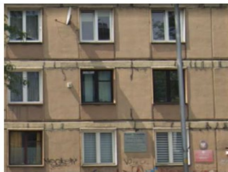
Рис. 1. Крупноблочная технология с разделением на фасадные и потолочные панели среднего размера [2]
