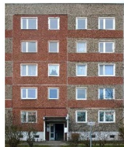
Рис. 2. Крупнопанельная технология с разделением на крупные фасадные и потолочные панели [3]
