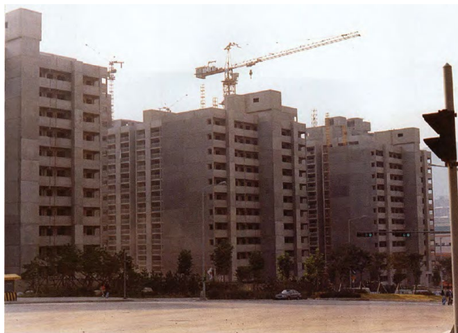
Рис. 5. Проект большого многоквартирного дома в Корее, который возведен с использованием системы Koncz для высотных крупнопанельных зданий [4]
