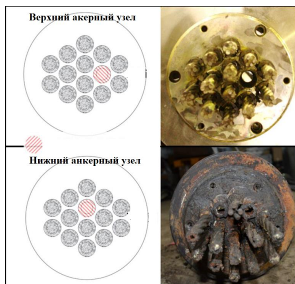
Рис. 16. Фактическое положение канатов, установленных в вантовой пряди № 10
