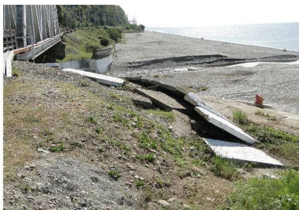
Рис. 1. Деформации у опор железнодорожных мостов: а – размыв от паводка; б – от наката морских штормовых волн
