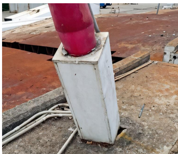
Рис. 17. Смещение защитного (антивандального/гидроизоляционного) короба
