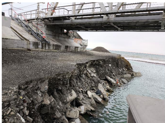
Рис. 1. Деформации у опор железнодорожных мостов: а – размыв от паводка; б – от наката морских штормовых волн
