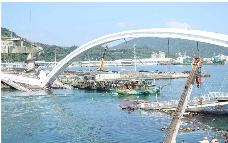
Рис. 1. Мост через гавань Наньфан-ао после обрушения пролетного строения
