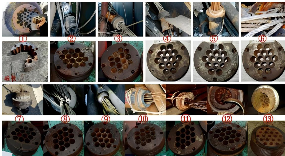
Рис. 18. Состояние анкерной пластины и высокопрочных прядей в уровне анкерных узлов: 1–13 – ванты и узлы
