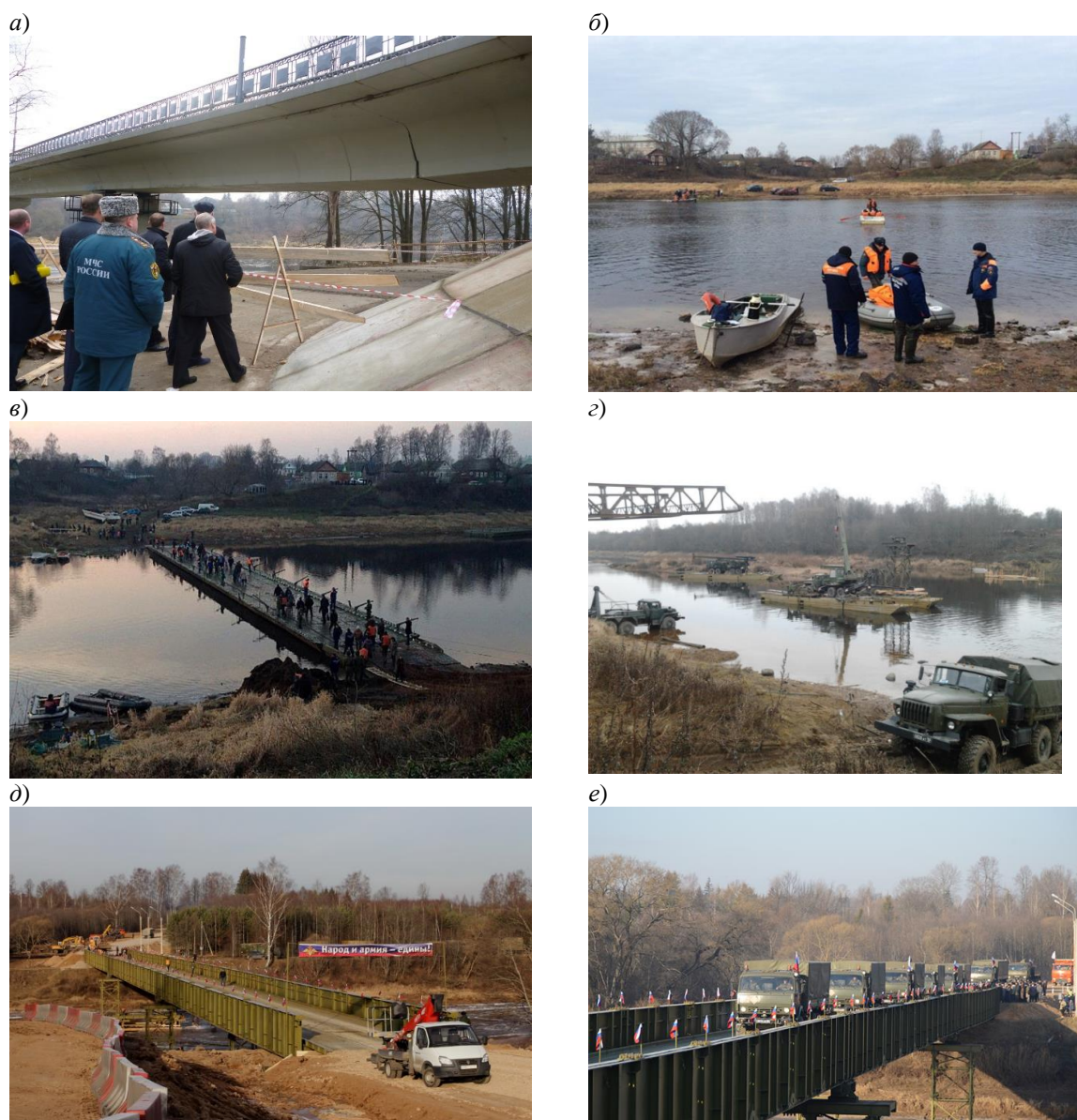
Рис. 1. Повреждения и поэтапное восстановление моста в г. Велиже: а – повреждения балки пролетного строения; б – инженерная разведка и обеспечение лодочной переправы; в – краткосрочное восстановление (наплавной мост); г – устройство временного большого автодорожного разборного моста (БАРМ); д, е – готовый БАРМ
