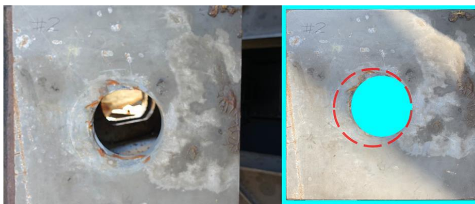
Рис. 14. Несоосное расположение отверстий при наложении друг на друга опорных пластин и расхождение в диаметре отверстия
