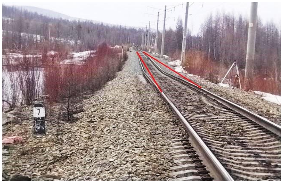
Рис. 1. Искривление продольного профиля участка железной дороги и осадка земляного полотна из-за протаивания льдистых грунтов основания
