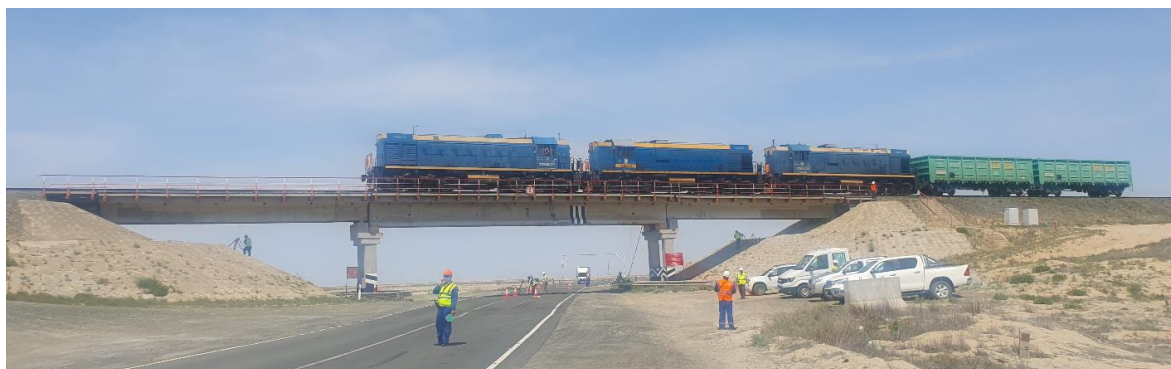
Рис. 1. Железнодорожный путепровод под испытательной нагрузкой (2-я ступень загрузки)
