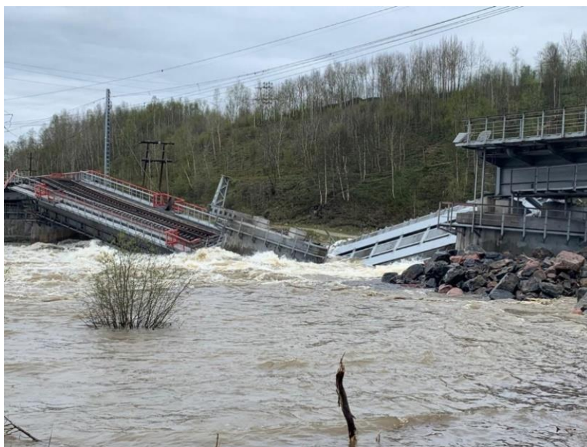
Рис. 1. Обрушение моста через р. Колу
