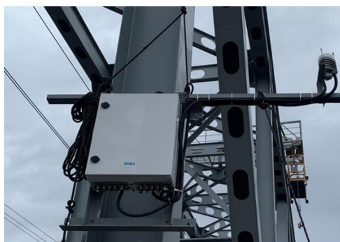
Шкаф метеоконцентрации и метеостанция: Стойка 3-3'
