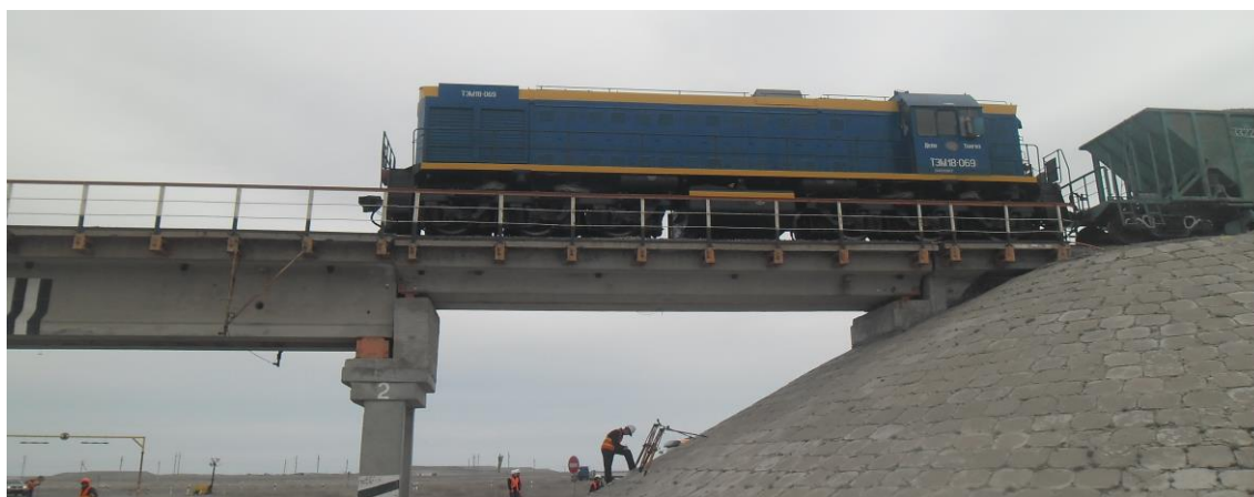
Рис. 3. Проведение испытаний конструкций пролетного строения с помощью 6-осного тепловоза ТЭМ18 и 4-осного хоппер-дозатора
