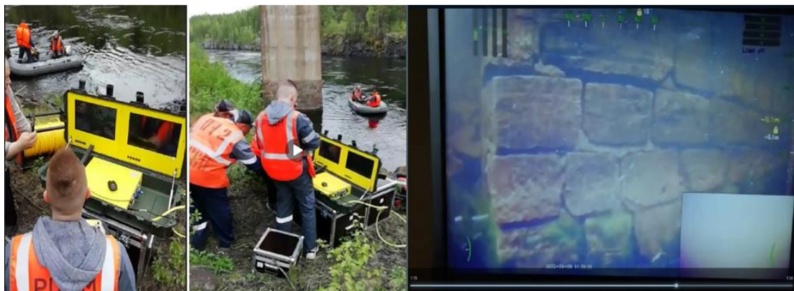
Рис. 3. Процесс обследования подводной части русловой опоры
