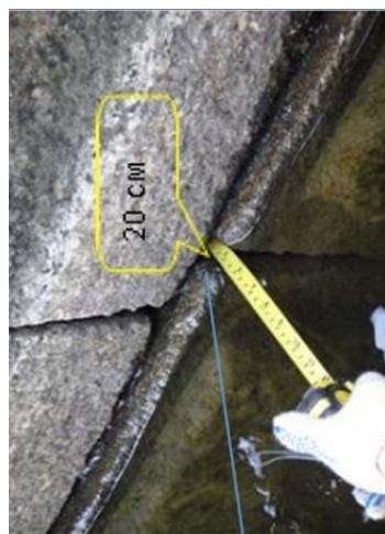
Опора № 1. Пустые швы между камнями облицовки ледореза в зоне переменных вод (до 20 см)
