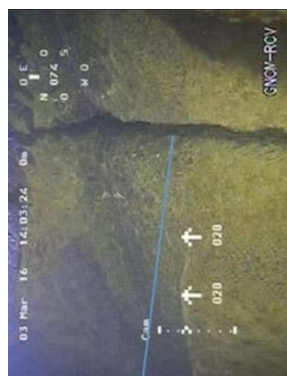
Опора № 1. Пустые швы между камнями облицовки ледореза в зоне переменных вод (до 20 см)
