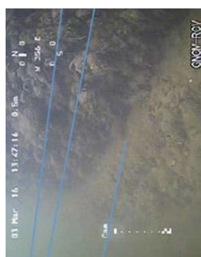
Опора № 1. Пустые швы между камнями облицовки ледореза в зоне переменных вод (до 20 см)
