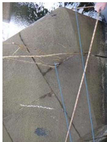
Опора № 1. Пустые швы между камнями облицовки ледореза в зоне переменных вод (до 20 см)
