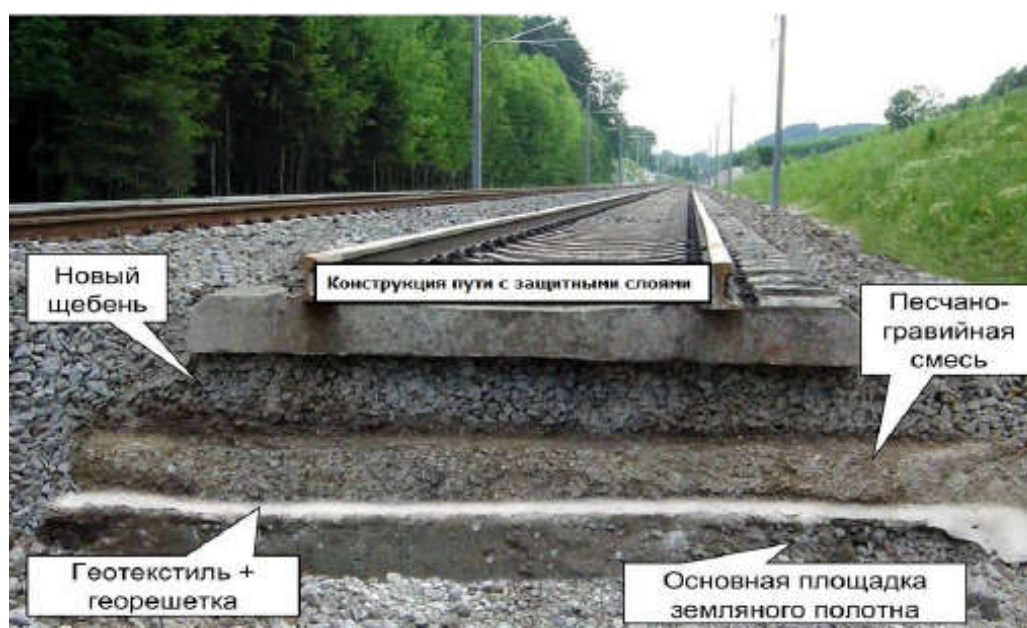
Рис. 1. Современная конструкция балластного пути [3]
